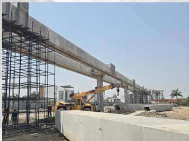
Hệ thống cầu trục chịu tải bằng bê tông cốt thép tại chỗ
