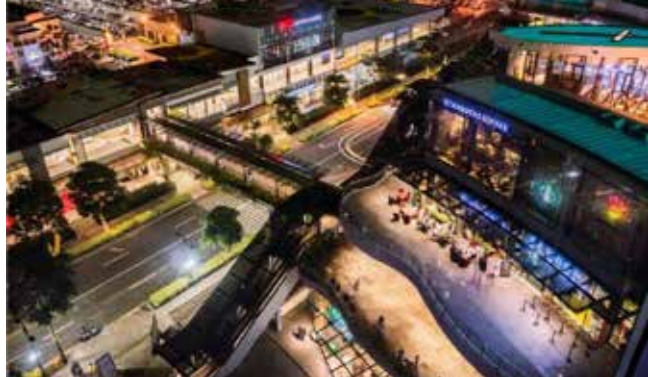
Cầu vượt bộ hành kết nối trực tiếp các tòa nhà thương mại trong khu vực CBD Bonifacio Global City (Nguồn: Internet)
