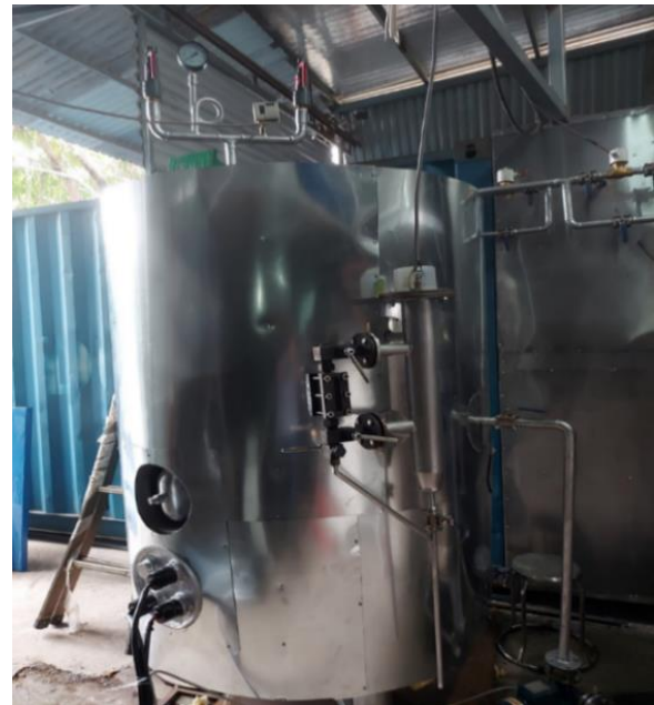
Hình 2.2. Lò hơi điện công suất 30kW
