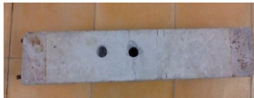
Hình 4. Lỗ khoan bê tông tại vị trí nứt và vị trí không nứt
