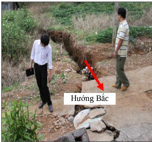
Hình 6. Vết nứt sụp trước căn nhà số 135/33/15, rộng 30cm, sụp sâu 50cm
