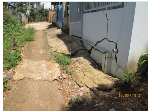
Hình 8. Các vết nứt sụp làm biến dạng tường nhà
